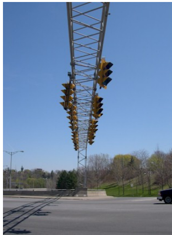
Figuur 22: Gantry boven autosnelweg
