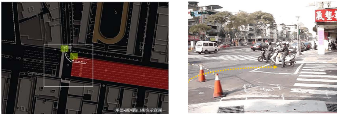
圖 11 承德橋北向承德-通河路口，右轉車輛與通河街路口停等待轉區相衝突(左上方綠色框處)；最外側機慢車道右轉轉彎半徑同樣不足易肇事撞致承德橋邊欄杆(左下方綠色框處)。資料來源：本研究繪製。
