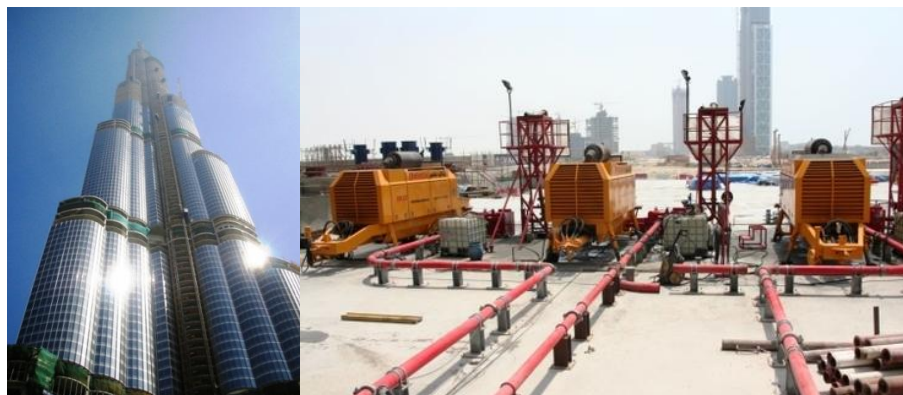
Figure 1-3 La tour et l'installation de pompage
