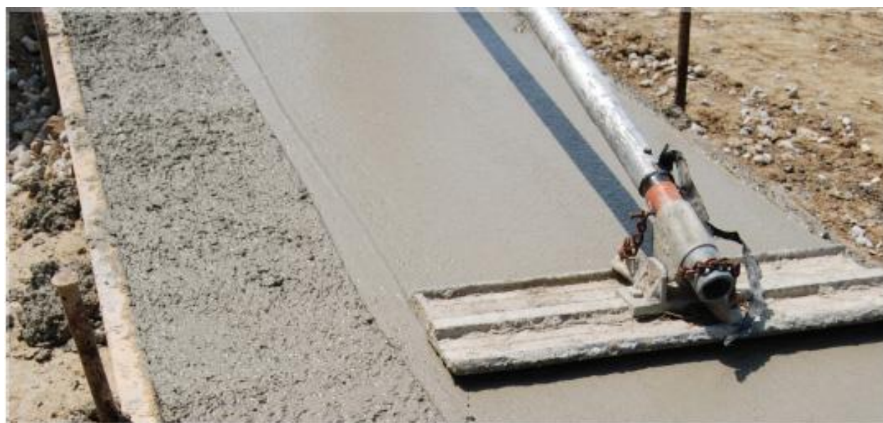
Figure 1-48 Finition par talochage après coulage du béton ( http://www.altaviewconcrete.com/ )
