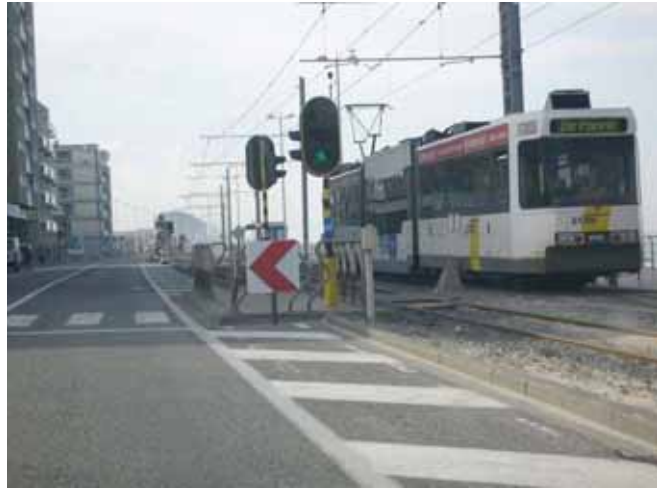
Voetgangsoversteekplaats Kusttram (Oostende)
