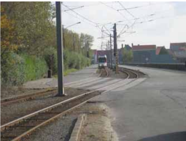
Overgang trambaan van centrale naar zijligging
