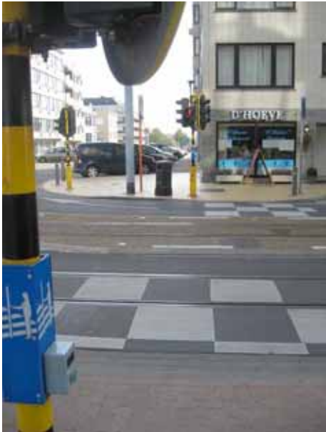
Dambordmarkering als voetgangersoversteekplaats
