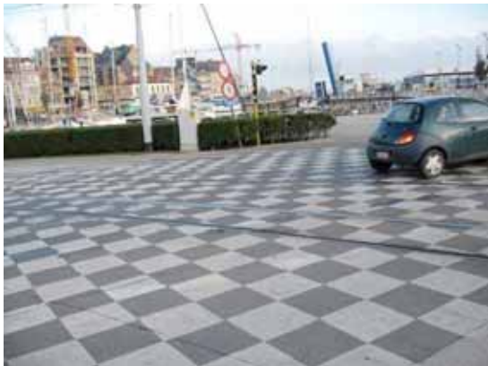
Zeer ruime toepassing dambordmarkering (over volledig kruispunt)
