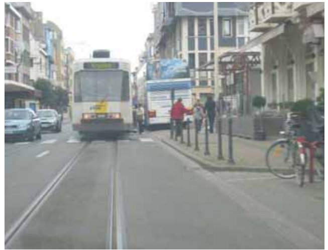
Fout gepositioneerde oversteekplaats aan halte (De Panne)
