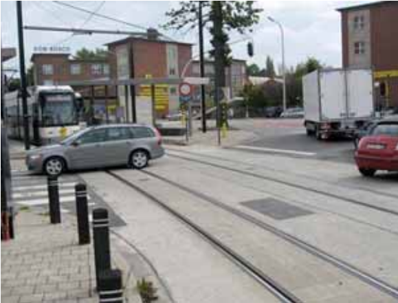
Vrije tram- & busbaan Kortrijksesteenweg en gemengd verkeer op Derbystraat, Gent
