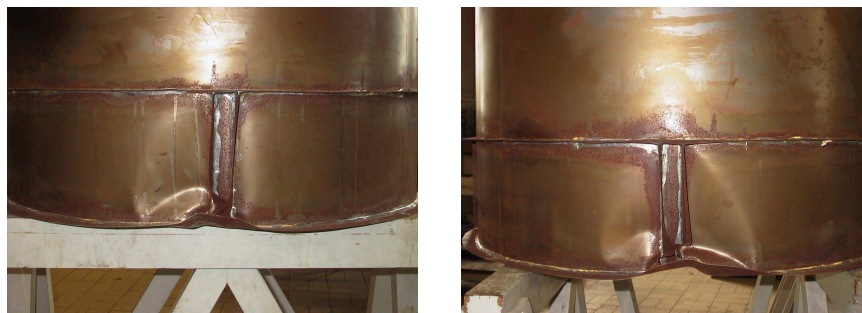
(a) Steunpunt N° 3
