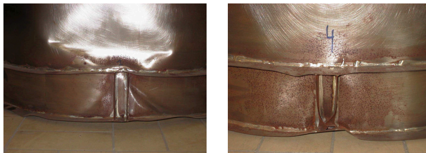
(a) Steunpunt N° 1
