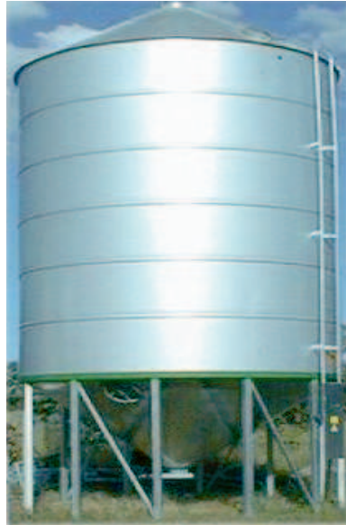
Figuur 2.1: Een stalen silo op een beperkt aantal kolommen.
