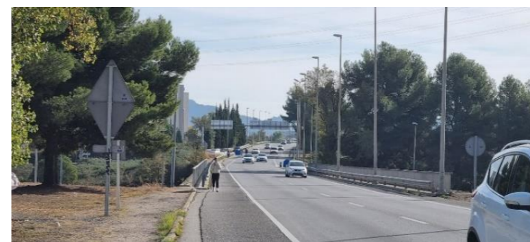
Figura 59 N-150 en su paso por Barberà del Vallès
