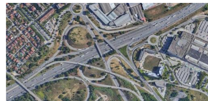
Figura 63 Nudo de separación entre Barberà del Vallès y Ripollet.
