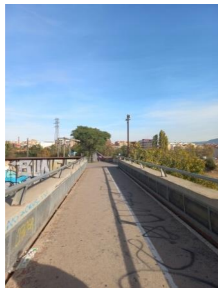
Figura 72 Puente de Ripollet que pasa por encima del río Ripoll
