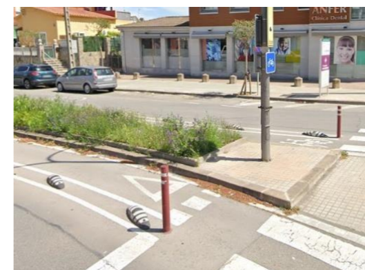
Figura 172 Inicio del carril bici de la calle de l'Urgell
