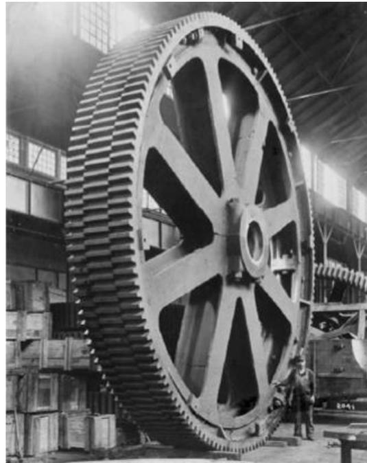
**Fig. 2** Roda cilíndrica exterior de dentes inclinados de primeira geração
