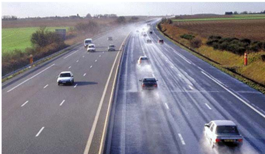
Figura 1 – Diferença na visibilidade com chuva entre um pavimento com camada de desgaste convencional, na faixa da direita, e com camada de desgaste drenante, na faixa da esquerda (GRAMME, 2009)
