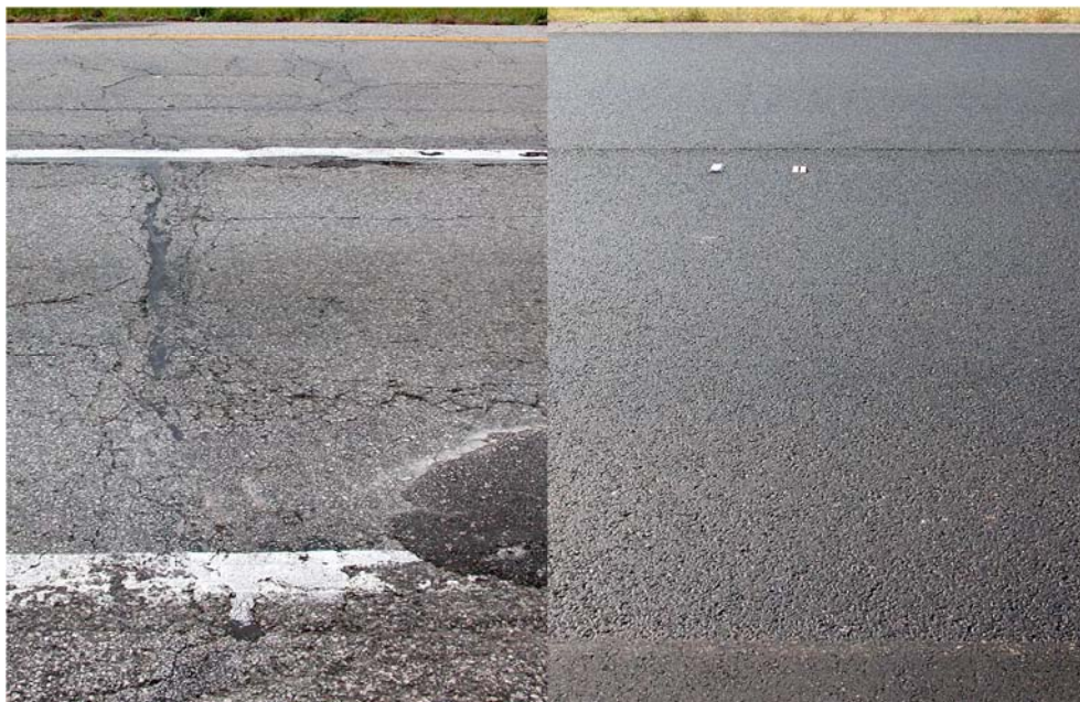
Figura 19 – Superfície de um dos pavimentos analisados antes e depois da reabilitação superficial (Amos, 2006)
