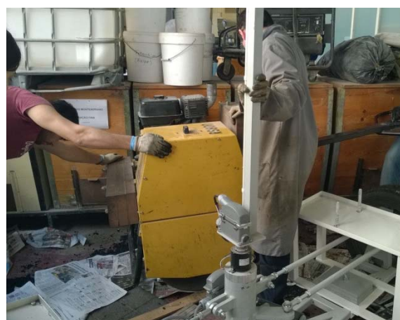
c) Compactação com o cilindro
