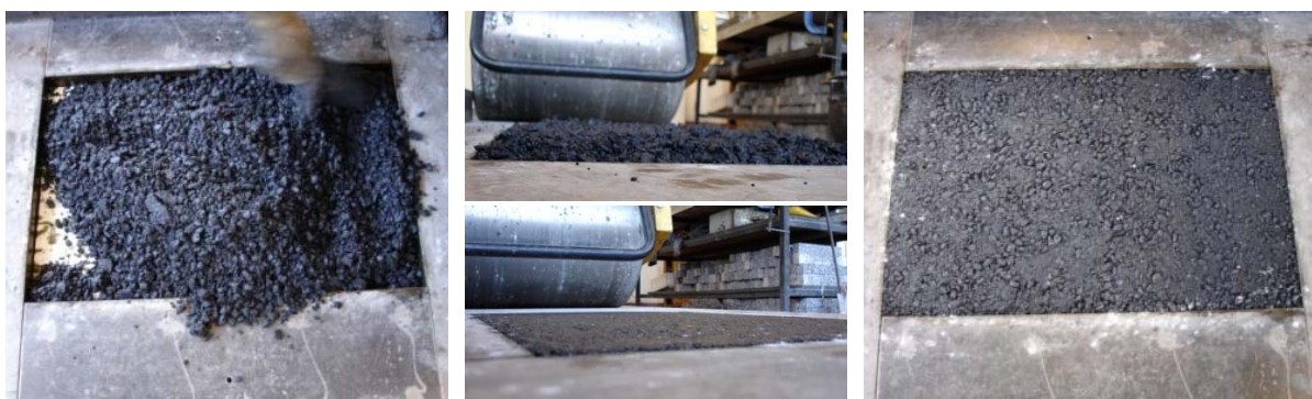
Figura 62 – Processo de espalhamento e compactação das misturas betuminosas
