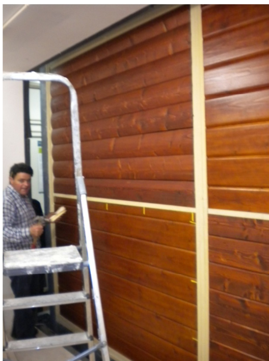
Figura 39 - Vista interior do provete 3, solução construtiva tronco 12 cm de espessura
