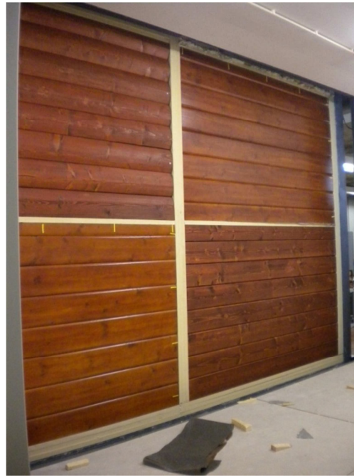
Figura 69 - Vista geral interior
