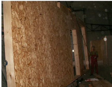
Figura 24 – Módulo pronto para acabamentos finais ( http://frame-house.eu )
