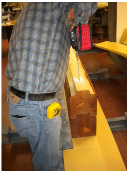
Figura AI- 4 - Fixação entre troncos através de parafusos.
