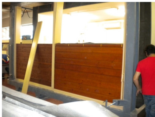
Figura AI- 6 - Provete 4 representativo da solução construtiva Clóvis após a sua colocação no pórtico de ensaio.
