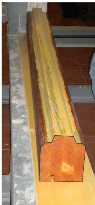
Figura AI- 3 - Tronco de arranque para solução construtiva tronco maciço de 16cm de espessura.
