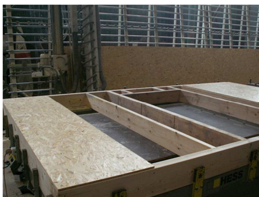
Figura 22 - Colocação da placa de OSB ( http://frame-house.eu )
