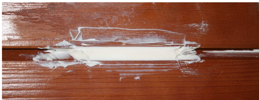
Figura 52 - Preenchimento da zona de junta com pasta de dentes
