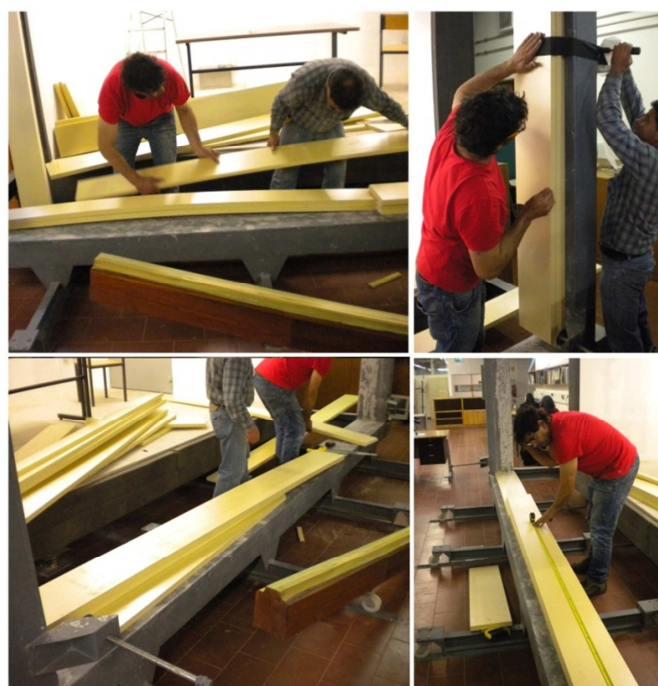
Figura AI- 2 - Colocação do isolamento térmico no pórtico.
