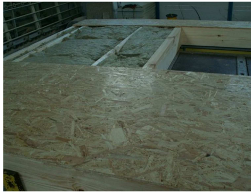
Figura 23 - Colocação da placa de OSB ( http://frame-house.eu )
