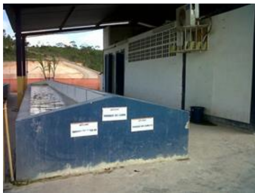
Figura 8.20: Tanque para cura dos CPs
