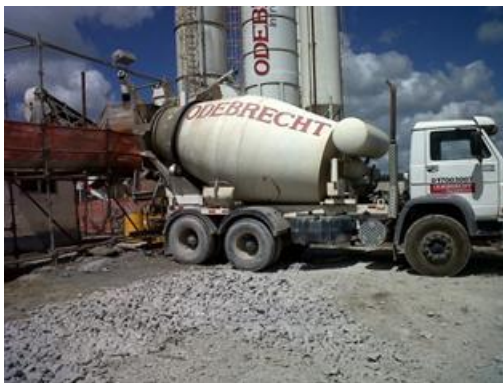
Figura 8.18: Fabricação do concreto na central
