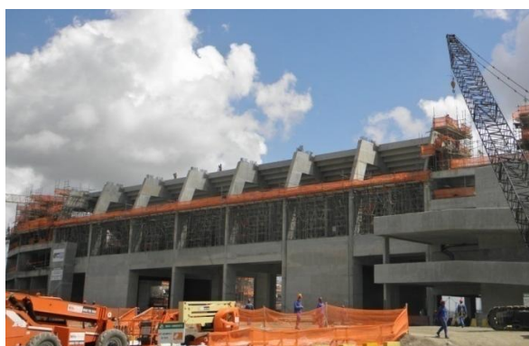
Figura 8.4: Vista da fachada sul
