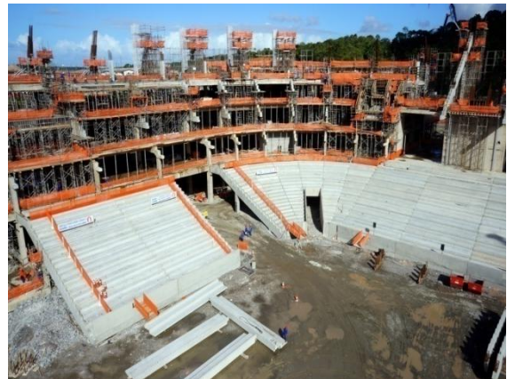
Figura 8.9: Arquibancada inferior leste
