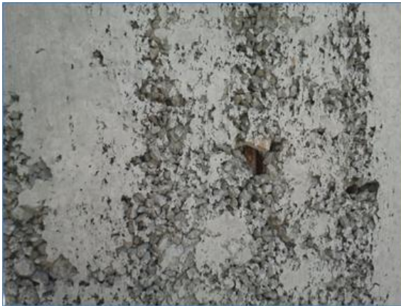
Figura 8.13: Superfície sem qualidade
