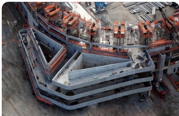
Figura 8.10: Rampa de acesso à arquibancada
