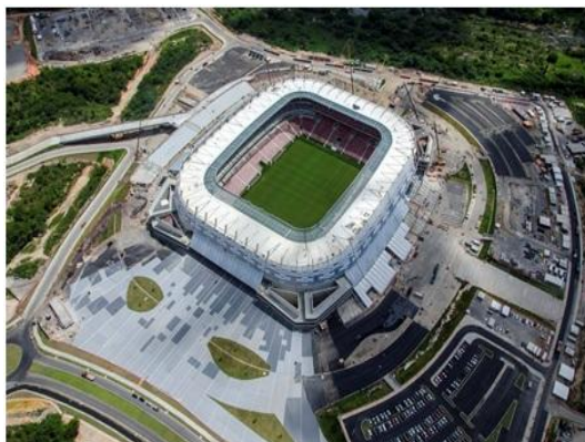
Figura 8.34: Fotografia aérea da Arena Pernambuco em conclusão no ano de 2013.
