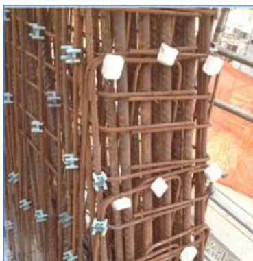
Figura 8.12 – Armação de pilar Arena – PE – Julho 2012.
