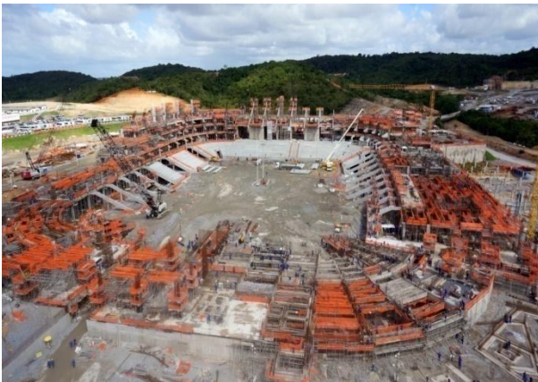
Figura 8.8: Vista aérea noroeste-sudeste
