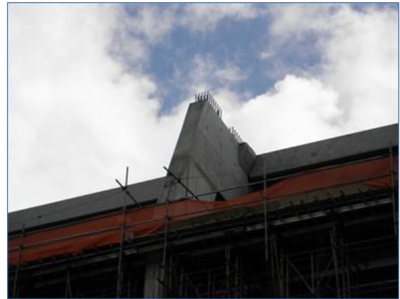
Figura 8.14: Superfície com acabamento uniforme
