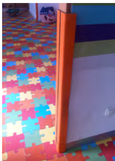
Figura 6: Exemplo de uma proteção da aresta da parede
