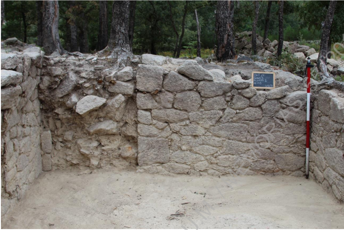
Sondagem 5 - Alçado 2 – UE 053. (IMG_1696).
