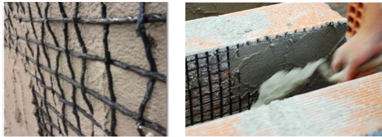
Figura 15: Construção dos provetes e aplicação da malhas de reforço de varões entrançados
