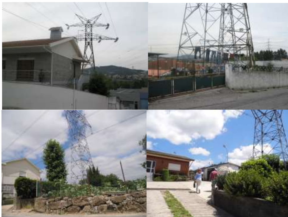
Figura 2 – Postes de alta tensão fazem parte dos quintais das habitações em Serzedelo Fonte: Trabalho de campo realizado em Junho de 2014.
