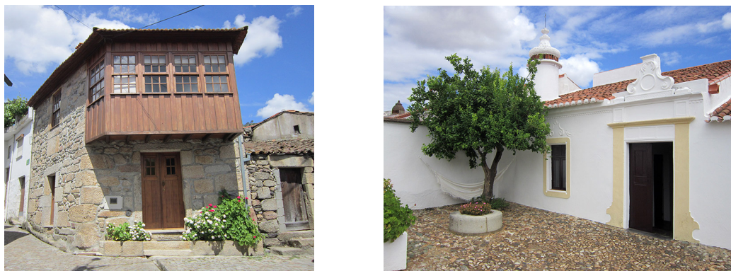
Figura 2 (a) Caso de estudo 1 - Habitação com varanda envidraçada orientada no quadrante sul, Beira Alta. (b) Caso de estudo 2 - Habitação no Alentejo.
