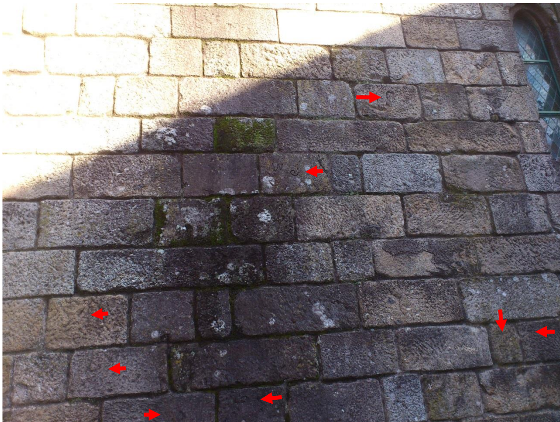
Anexo residencial (fotografia: Paula Bessa)
