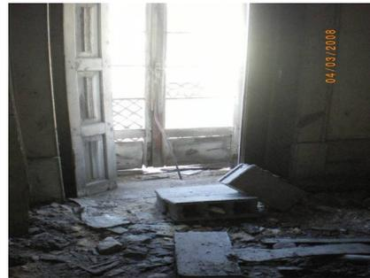
Foto 8 - Aspectos visíveis da deterioração das portadas, janelas e de sujidades no chão
