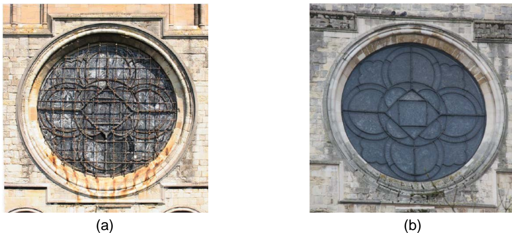
Figura 3. Oculus: (a) sul (antes do restauro); (b) norte (depois do restauro).
