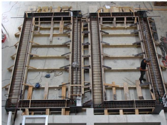
Figura 9. Pormenorização das armaduras visível antes da betonagem.
