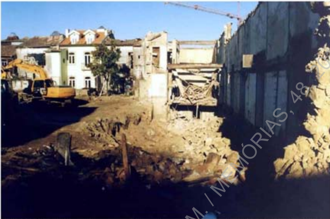
Foto 13 (1973) – Vista geral do espaço a ser intervenido – trabalhos de demolição do edifício (S/N ©CMB).
