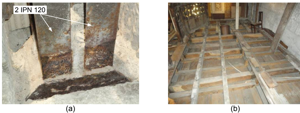
Figura 5 – Pormenores (a) da fundação e (b) do vigamento do pavimento.
