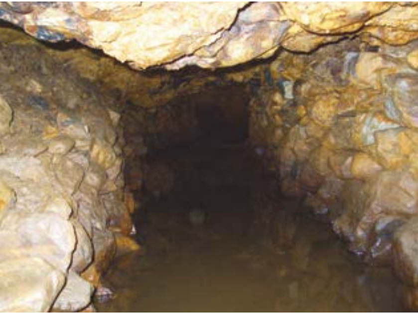
Figura 6 Galería inferior de la explotación subterránea de la Barrerica Blanca ("Cueva del Maestro", Luyego-León). Obsérvense los muros de sostenimiento realizados con los cantos gruesos del aluvión.
