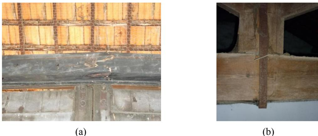
Figura 7 – Danos e patologias; (a) Rotura de elemento devido à colocação de uma cavilha; (b) Deformação de uma asna com consequência na ligação entre pendural e linha.
