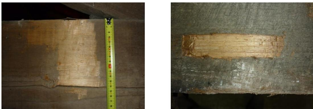
Figura 4 – Inspeção da camada superficial e anéis de crescimento para determinação da espécie de madeira.
