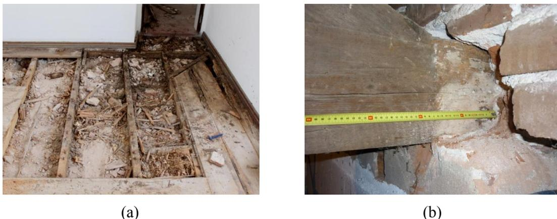
Figura 5 – Acessibilidade a elementos escondidos através de: (a) Abertura de janelas de inspeção; (b) Remoção de elementos vizinhos.
