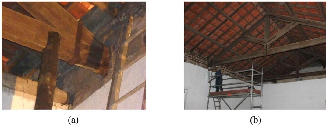
Figura 2 – Medidas preliminares; (a) Colocação de elemento para suporte de uma asna; (b) Uso de andaimes para acesso próximo à estrutura de cobertura.
