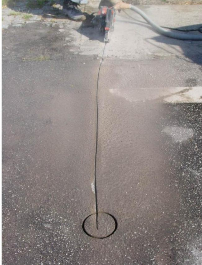
Figura 5.4 – Abertura de rasgo entre os dois furos para colocação dos cabos dos materiais piezoelétricos
