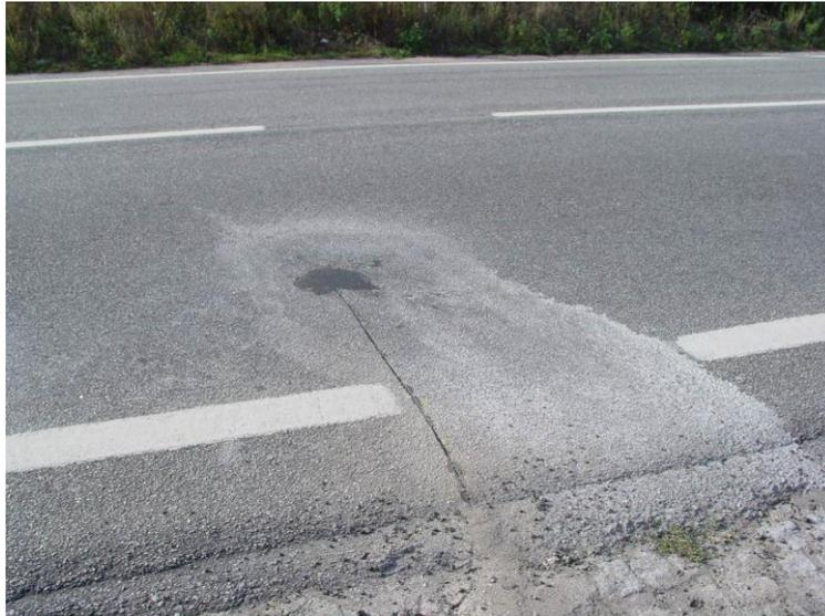
Figura 5.9 – Aspeto final depois da instalação dos materiais PVDF e PZT na estrada
