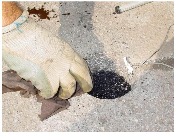
Figura 5.6 – Colocação de mistura sobre os materiais piezoelétricos
