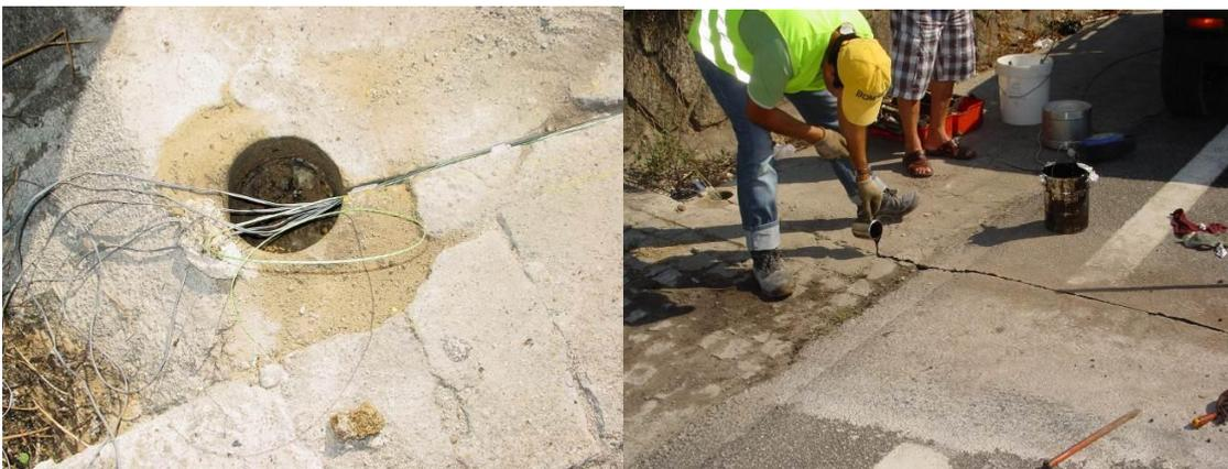
Figura 5.8 – Colocação dos cabos no rasgo e selagem do rasgo com betume asfáltico
