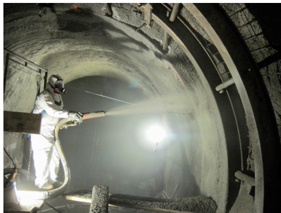
Figura 2- Aplicação do betão projectado (Transgulf)
