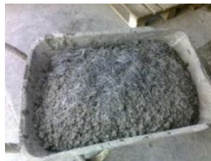
Figura 75 - Homogeneização da mistura betão com fibras
