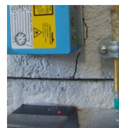
Figura 86 - Revestimento na chapa reflectora
