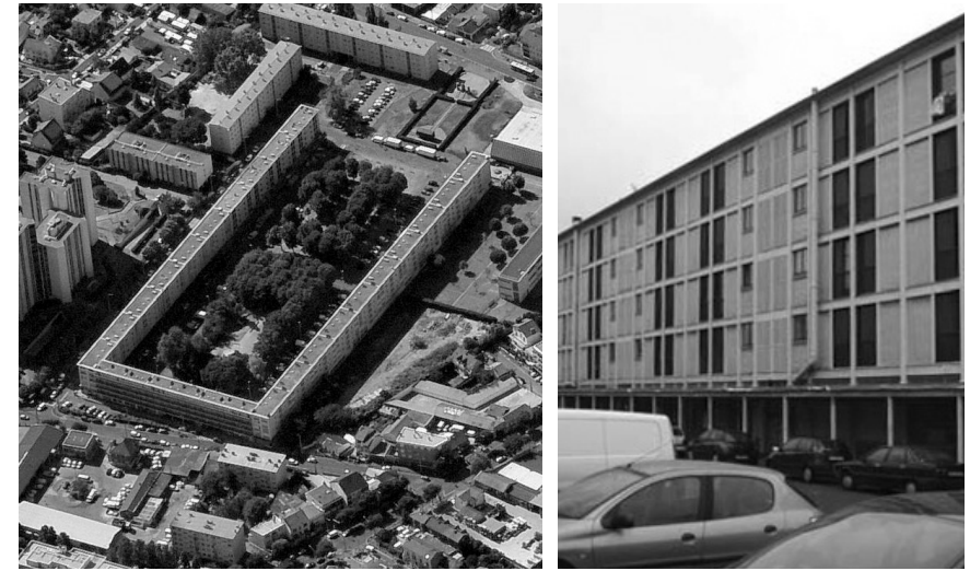
FIG. 6 La Cité de la Muette aerial view.
