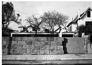
FIG.6 House on Rua do Padrão.
