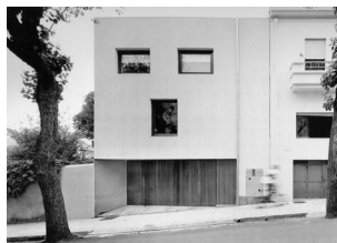
FIG.7 House on Rua do Crasto.
