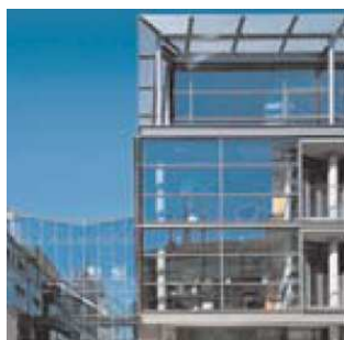
a. Fachada com isolamento Térmico.
