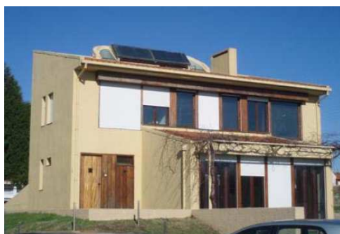
Figura 3.35 Casa Termicamente Otimizada – Fachada Sul, Porto. Arquitetos Carlos Araújo e Santiago Boissel.
