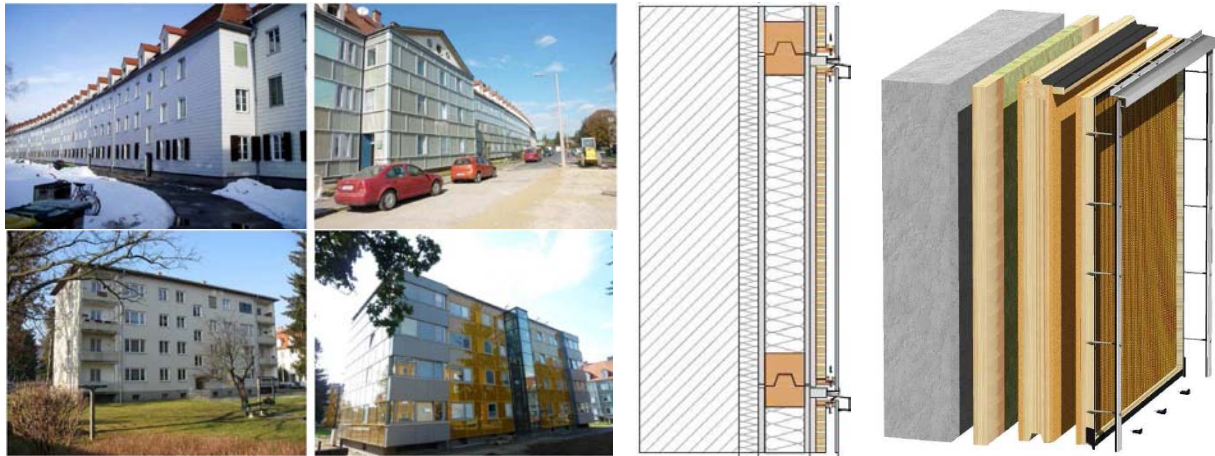
Figura 3.78 Graz-Liebenau (Dieselweg) na Áustria (1950), antes (esquerda) e depois (direita) da reabilitação.
