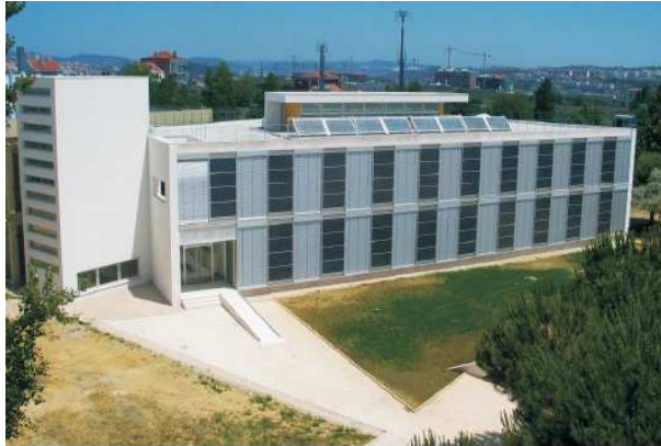
Figura 2.3 Edifício Solar XXI Fonte: INETI, 2005.
