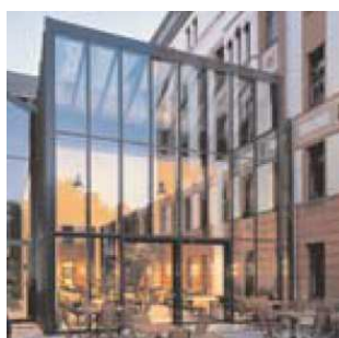
g. Fachada com proteção contra o fogo.
