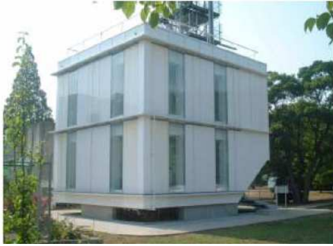
Figura 3.76 Edifício de testes com fachada revestida com material foto catalisador, Noda-shi, Chiba, Japão (2004).
