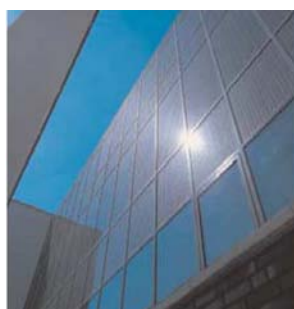
j. Fachada com Fotovoltaicos.
