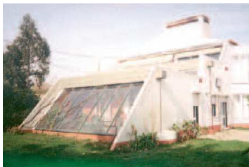
Figura 3.15 Moradia Unifamiliar com Estufa – Vale do Rosal. Inverno e verão com proteção de vegetação. Arquiteto Fausto Simões.
