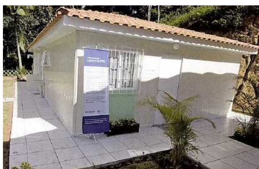
Figura 3.60 Habitação com as fachadas construídas em PVC preenchido com betão e aço.
