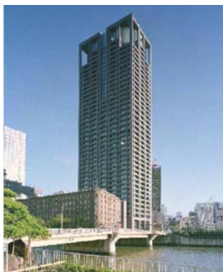
Figura 3.72 Edifício Power, Osaka – Japão, 2005. Fonte: ASCHEHOUG; ANDERSEN (2008).
