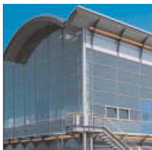
b. Fachada com alto isolamento térmico.
