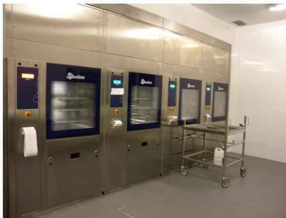
**Figura 26 - Máquinas de Lavagem Mecânica – Zona de Inspeção dos D.M.**
