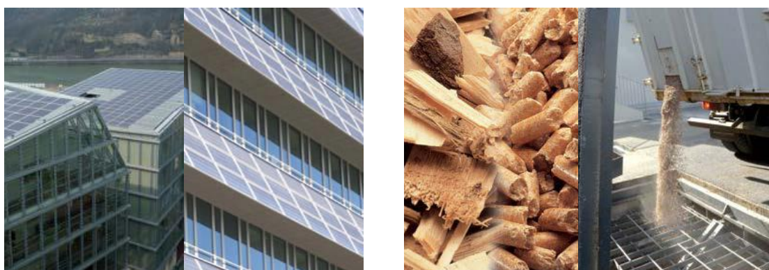
Figura 15. Combinação do uso de painéis solares (telhados e fachadas) e lenha para as caldeiras (Renaissance, 2013)
