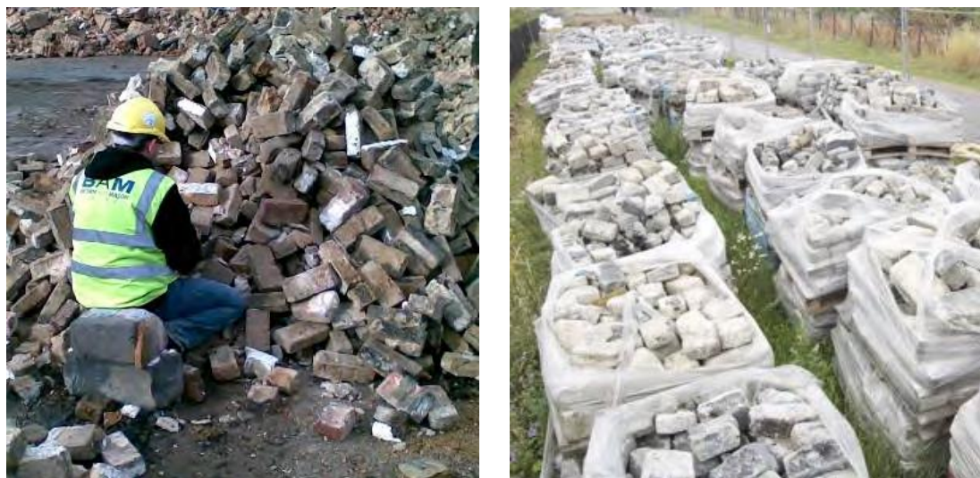
Figura 17. Separação manual de tijolos e seu armazenamento para reutilização (BioRegional, 2011).
