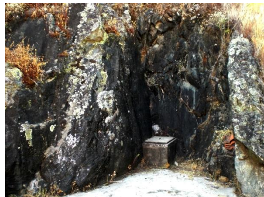
Figura 78: Poço de captação da água termal.
