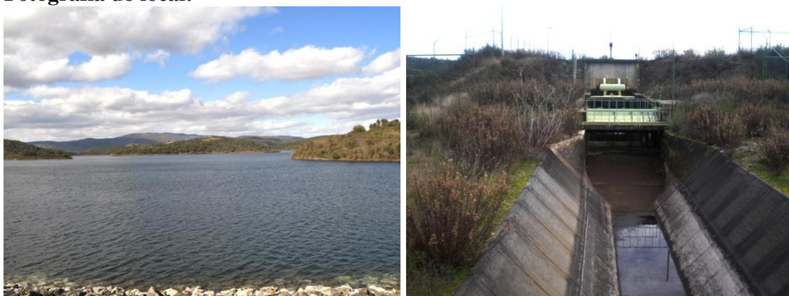
Figura 74: Foto à esquerda a albufeira da barragem do Azibo (foto: Pedro Pimenta); à direita mecanismo utilizado para encaminha a água para regadio.
