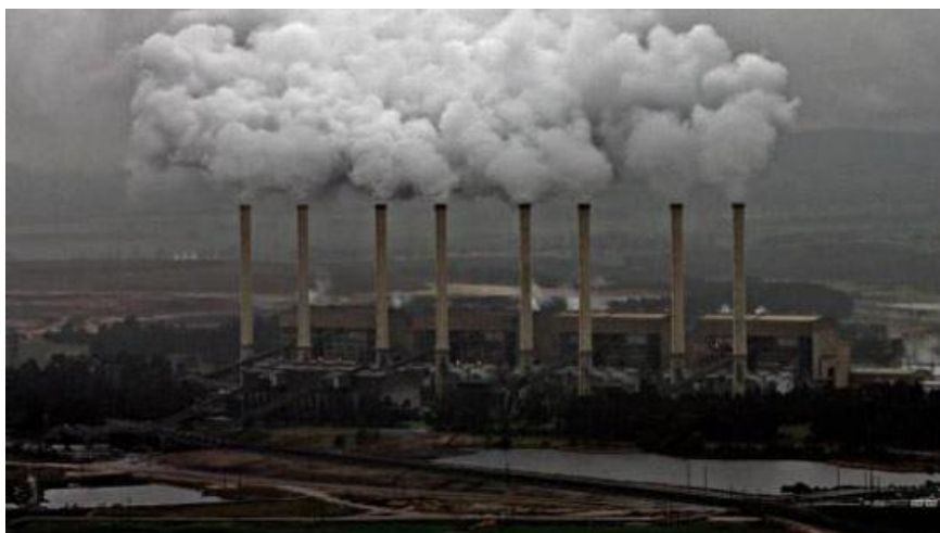
Figura 2 - Central termoelétrica a carvão em Hazelwood, Austrália
