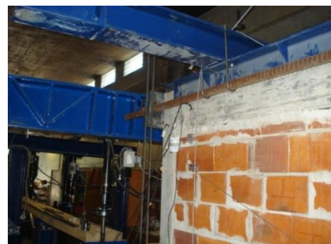
b) Vista geral do sistema de tirantes.
