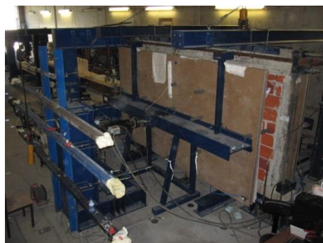
Figura 7.16 - Vista geral do painel colocado na infraestrutura de ensaio para fora do plano.
