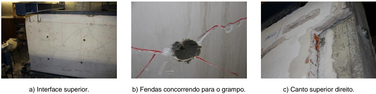
Figura 7.88 - Estado após o ensaio do painel Wall_DPA_02.
