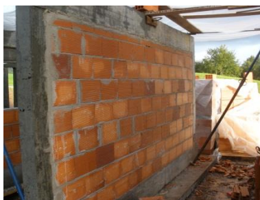
b) Aplicação da alvenaria.
