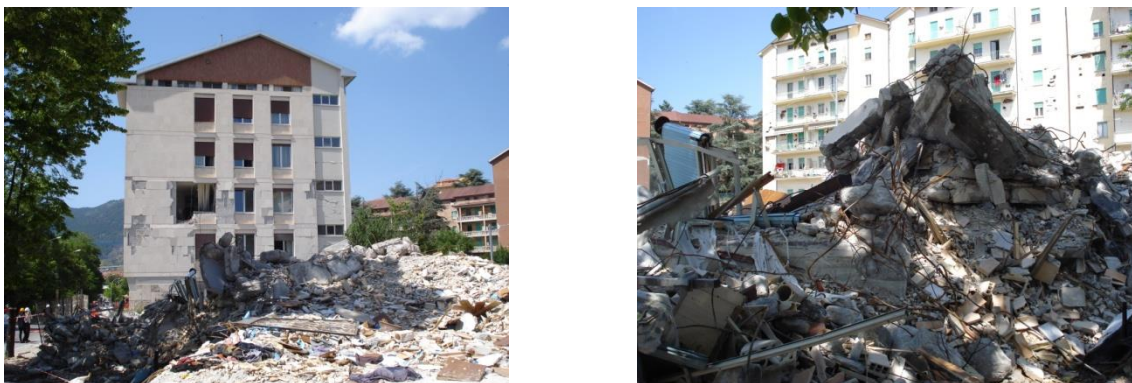
Figura 2.6 - Diferença de vulnerabilidade em edifícios. Sismo de L'Aquila (Fotografias do autor).
