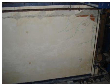
b) Vista geral após ensaio.
