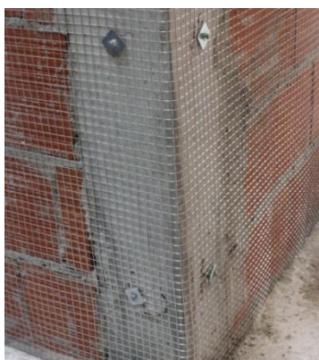
a) Malha de aço \varnothing 1.05 mm de 12.7x12.7 mm.
