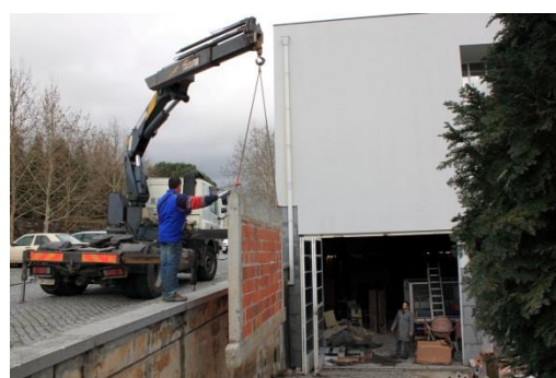
b) Movimentação dos painéis para o local de ensaio.
