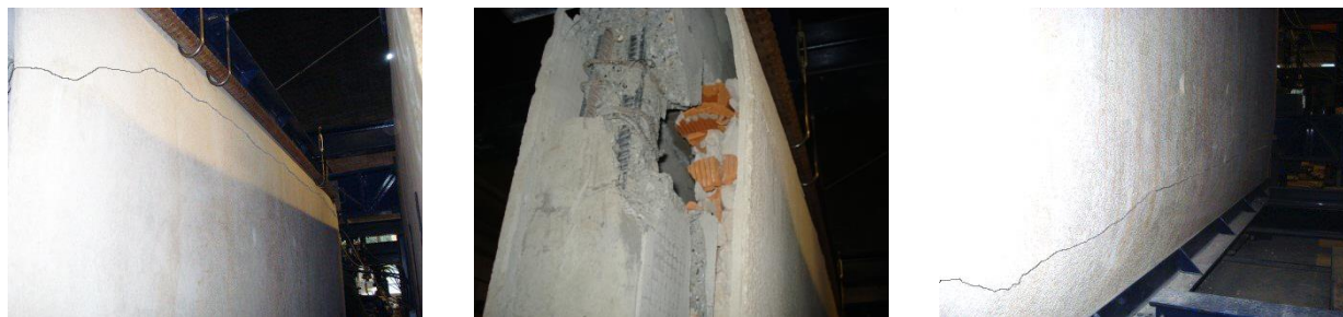
a) Fendilhação horizontal superior.
