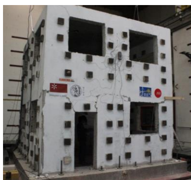
b) Fendilhação ao longo da viga do primeiro piso no alçado Norte.
