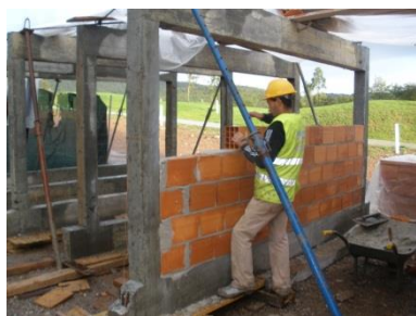
a) Início da construção da parede.
