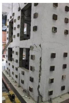
a) Destacamento do reboco no cunhal Sudeste.
