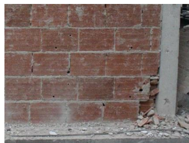
b) Parede do piso inferior do alçado Sul do Modelo 3.
