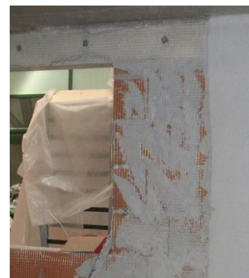
d) Aplicação de reboco.
