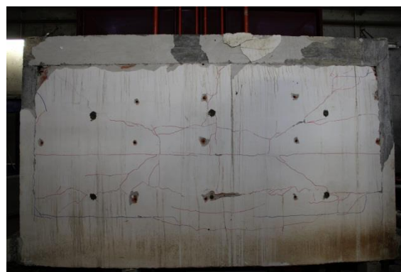
b) Vista geral após ensaio.
