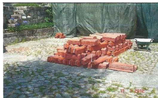
Figura 2-39 | Armazenamento condicionado dos materiais
