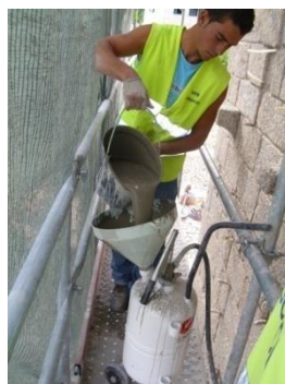
Figura 2-23 | Colocação com argamassa tradicional constituída por cal queimada em obra e areias de granulometria variada isentas de sais e de matérias orgânicas, e pó de pedra, em proporções na bomba manual
