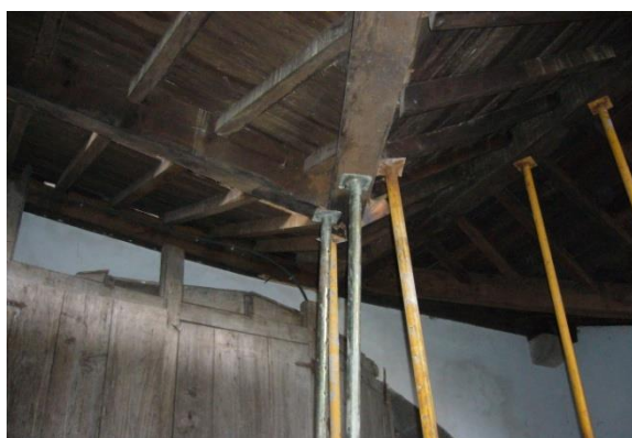
Figura 2-4 | Escoramento das vigas de madeira deterioradas
