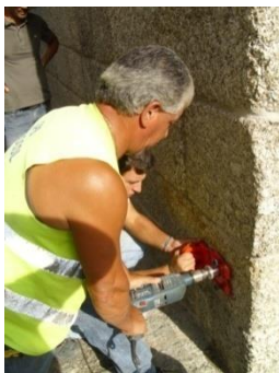
Figura 2-27 | Furação dos paramentos para colocação das pregagens nos cunhais com varão em 4 níveis e com cozedura dos panos de parede
