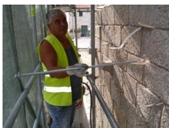
Figura 2-28 | Varão de aço Inox e paramento pronto para receber a calda de cimento
