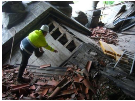
Figura 2-12 | : Inspeção do telhado e vigas da sala anexa ao coro-alto
