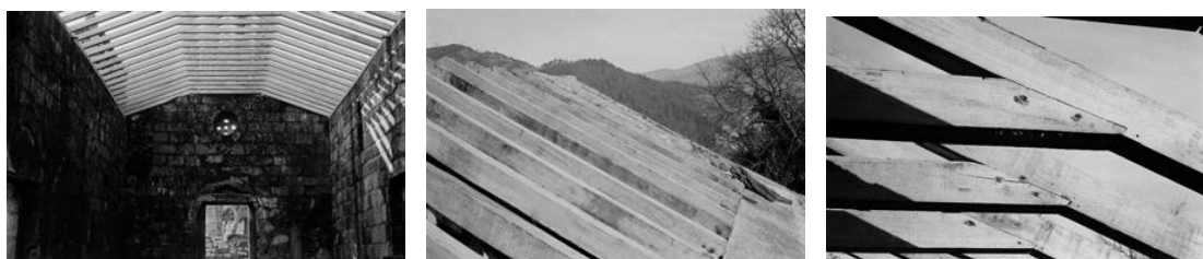
Figura 2-15 | Obras de construção da cobertura em 1985
