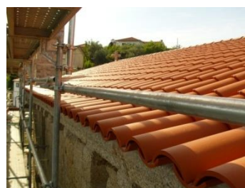
Figura 2-21 | Aplicação, para execução dos beirados, de telha cerâmica tipo nacional antiga para beiral, incluindo aplicação de membranas asfálticas auto adesivas sobre leito de argamassa pobre.
