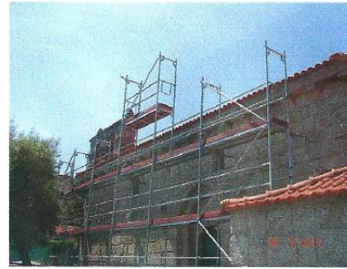
Figura 2-34| Colocação dos andaimes devem seguir o que foi definido no PSS pois estes devem estar montados a ultrapassar 1,30m da base do telhado, servindo assim de guarda corpos
