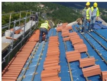
Figura 2-20 | Aplicação de telha cerâmica de capa e caleiro, de cor natural, incluindo cumes e babadouros no mesmo tipo de telha, armada em toda a sua extensão com grampos de cobre de diâmetro mínimo
