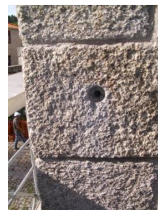
Figura 2-26 | Paramento com a extração do carote e furação executada
