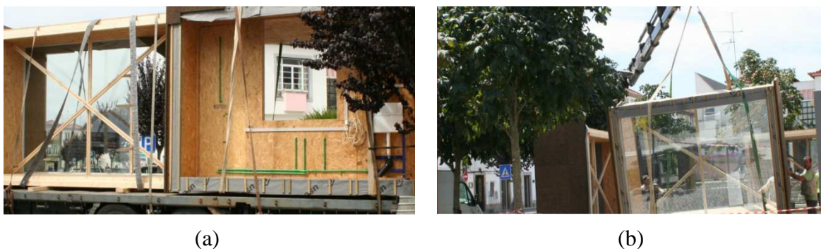
Figura 5 – Componentes de um sistema modular; (a) Transporte; (b) Aplicação em obra.
