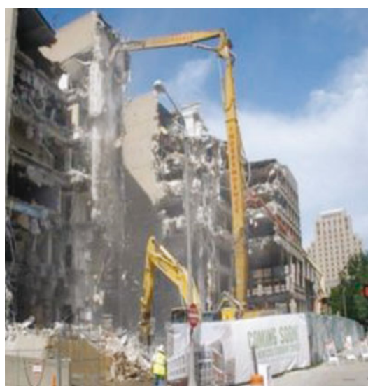
Figura 2: Operações de demolição de edifícios por manifesta obsolescência
