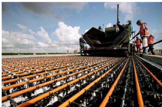
Figura 11 – Visão geral do Asphalt Solar Collector System (Bondt e Jansen, 2006)
