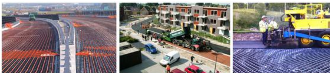
Figura 12 – Exemplos de Aplicação da solução Asphalt Solar Collector System (Bondt e Jansen, 2006; Sullivan et al. , 2007)
