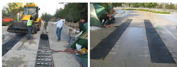
Figura 9 – Colocação do asfalto compactado sobre os geradores piezoelétricos (Innowattech, 2010)
