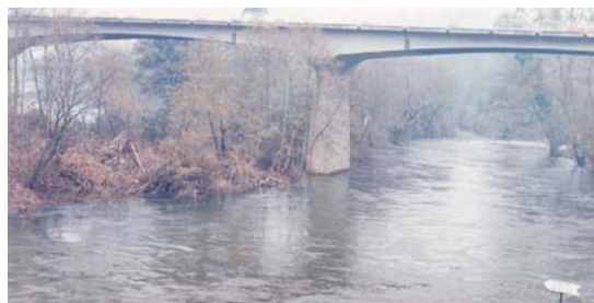
Fots. 24 e 25 - Aspectos da destruição provocada pelas cheias de Março de 2001 na Ínsua dos Frades
