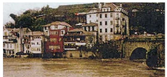
Fot. 21 - Efeito da cheia de 2001 sobre o pilar da Ponte de São Gonçalo (Fot. INAG, 2009).
