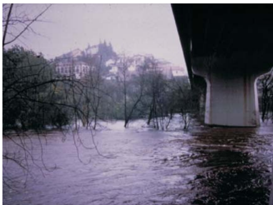
Fot. 13 - Pilares da Ponte Nova durante a cheia de 2001.
