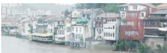
Fots. 17 e 18 - Aspecto das casas situadas ao longo da rua 31 de Janeiro na margem esquerda situadas do rio Tâmega, antes e durante as cheias de 2001.
