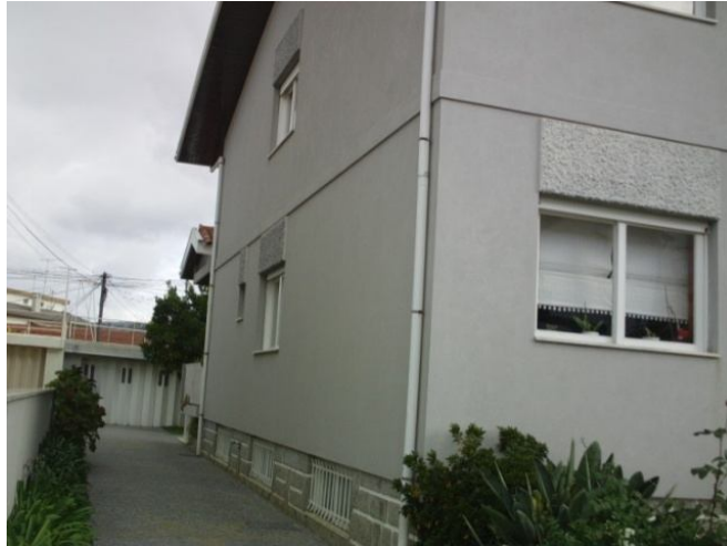
Fig. 17 Foto da fachada SW e parte da fachada SE, da moradia situada em Ferreiros
