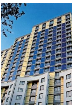
Fig. 79 Aplicação de painéis solares nas fachadas (Greentime, Oglobo, 2010)
