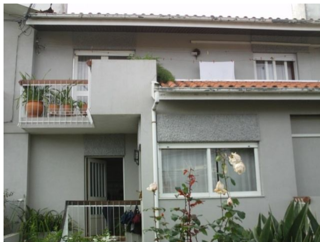
Fig. 18 Foto da fachada voltada a NW da moradia situada em Ferreiros
