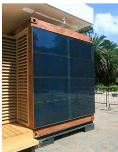
Fig. 78 Aplicação de painéis solares nas fachadas (Greentime, Oglobo, 2010)
