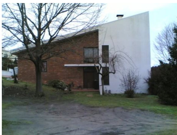
Fig.23 Foto da fachada SW da moradia de Nogueira
