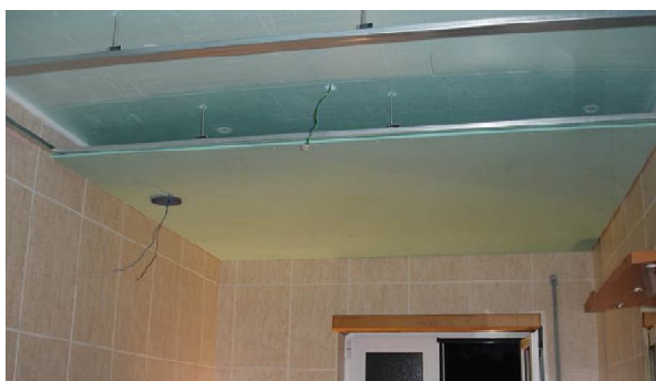
Fig. 68 Aplicação de XPS revestido por gesso cartonado hidrofugo (forum.aglobal, 2011)
