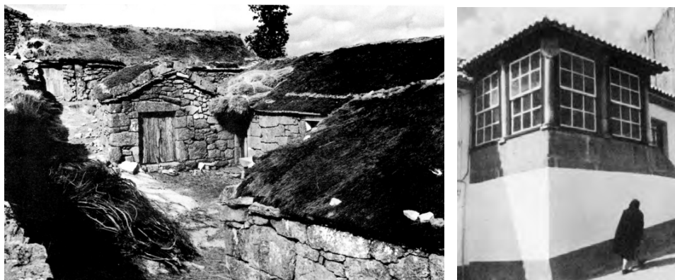
Figura 4 (esquerda) Coberturas em colmo, Bigorne; (direita) varanda, Guarda [24]
