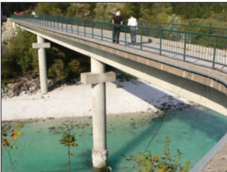
Figura 4: Ponte "Log Čezsoški" sobre o rio Soca na Eslovénia [14]
