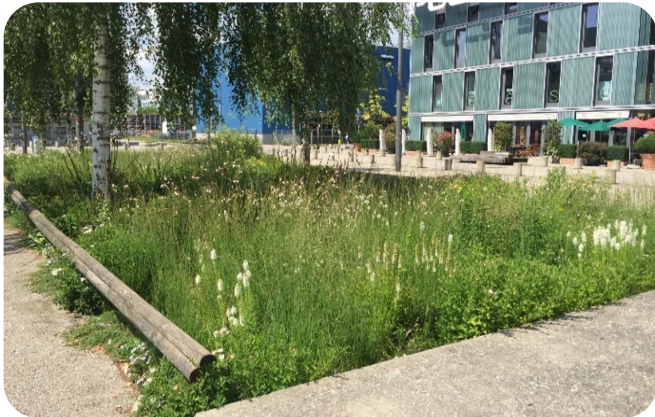
Versickerung mit Pflanzsubstrat, in die Platzabwasser mit geringer Belastung geleitet wird. ©Saluz
