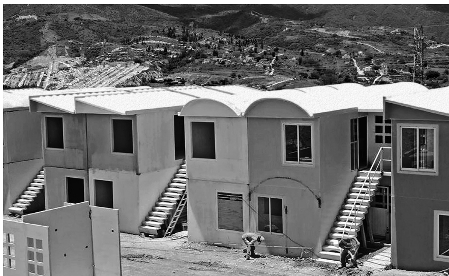
Imagen 7. Fraccionamiento Nuevo Mirador de Chilpancingo en etapa de construcción (2014).
