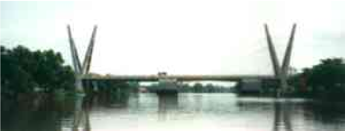
Figura 1.5 Puente Grijalva 1 (Fuente: Mexpresa).
