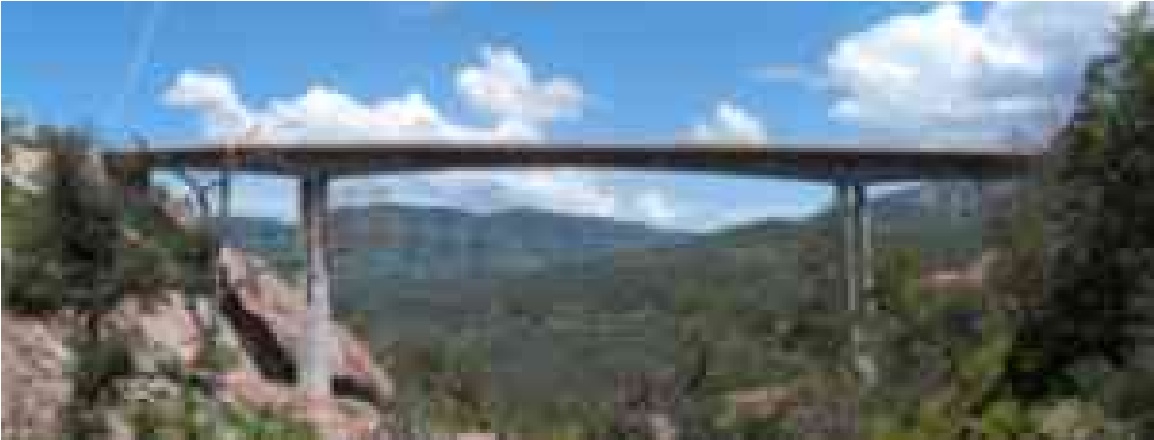
Figura 1.4 Puente Paso de Piedra (Fuente: Mexpresa).
