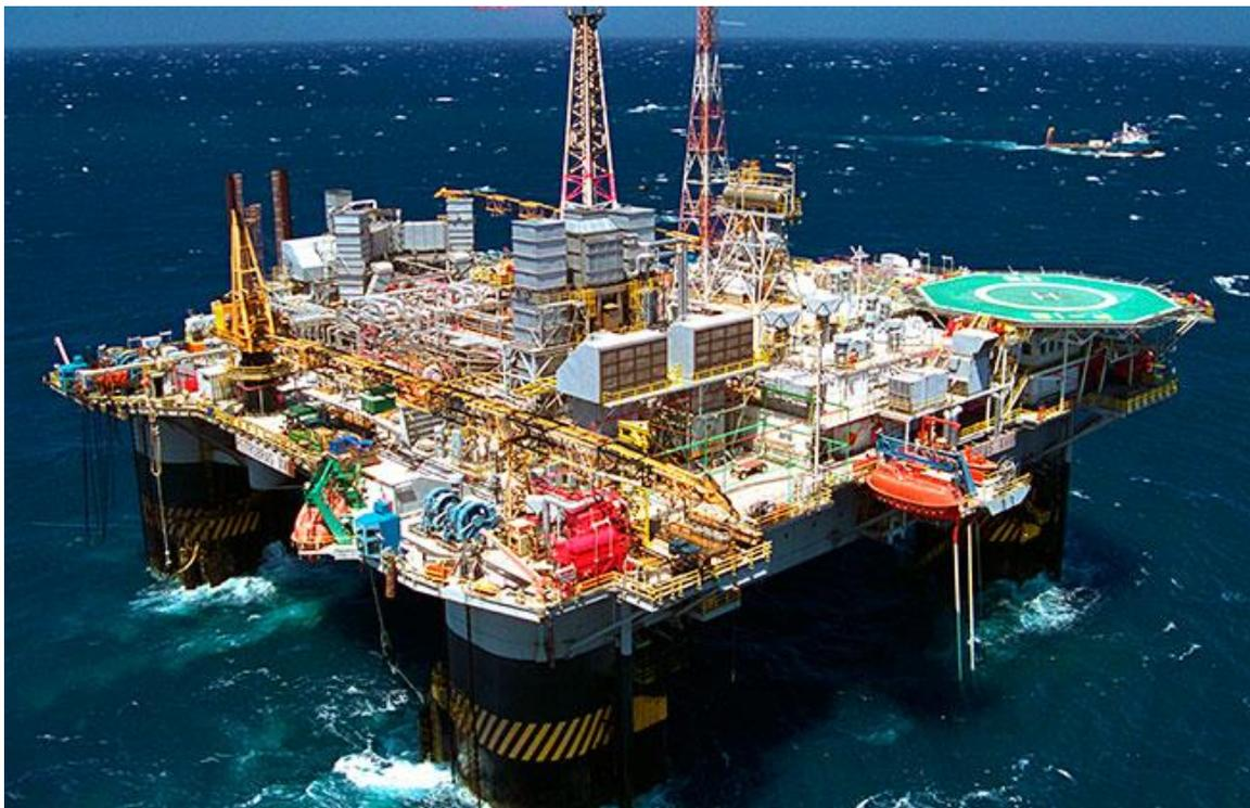
**Figura 1.3 Plataforma tipo semisumergible**
