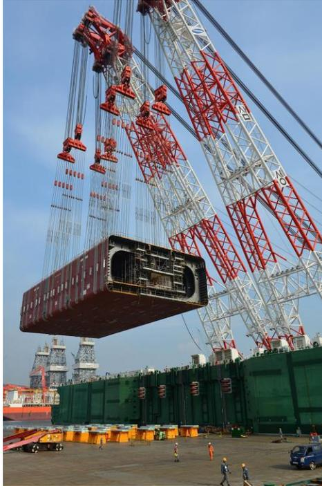
**Figura 1.6** Ensamble del casco mediante módulos (fuente: <http://www.inpex.co.jp>).
