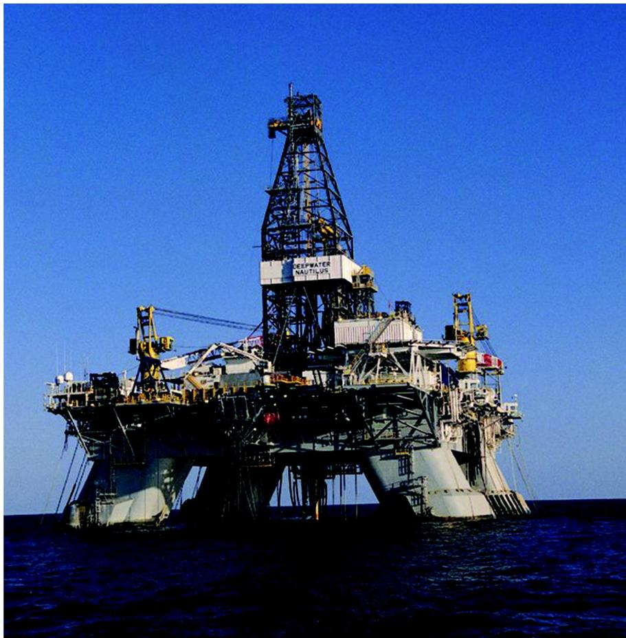
**Figura 2.4 *Deepwater Nautilus* plataforma tipo semisumergible de quinta generación (fuente: [https://petrowiki.org/File:Devol2\\_1102final\\_Page\\_603\\_Image\\_0001.png](https://petrowiki.org/File:Devol2_1102final_Page_603_Image_0001.png)).**
