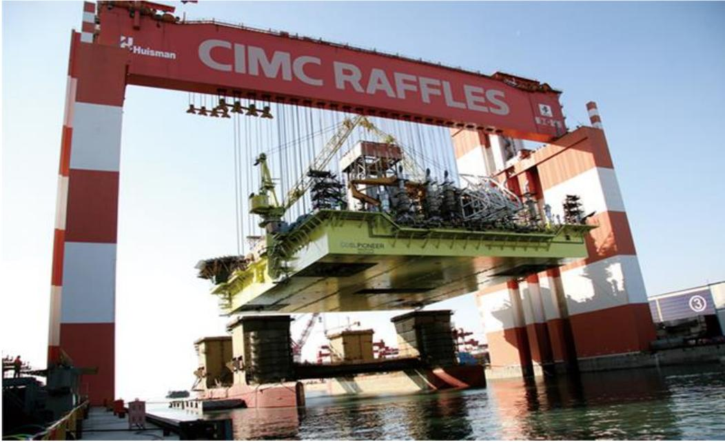
Figura 1.8 Elevación y acoplamiento de la cubierta sobre el casco (fuente: <http://web.cimc.com>).
