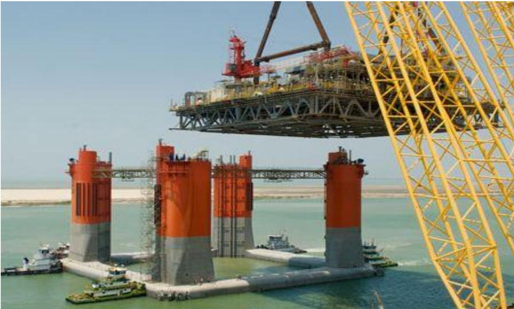
Figura 1.9 Acoplamiento de la cubierta y el casco (fuente: <http://www.kiewit.com>).
