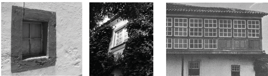
Figura 8. (à esquerda) Estratégias de redução dos ganhos solares em habitações de Évora (Fernandes & Silva, 2007); (à direita) Promoção dos ganhos solares em casa beirã (AAVV, 1980)
