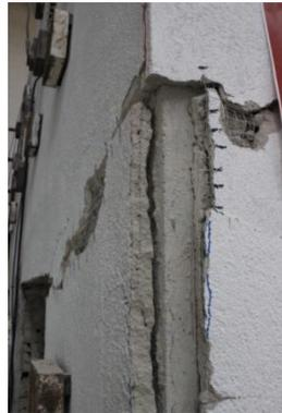
(c) Destacamento de reboco no canto Noroeste
