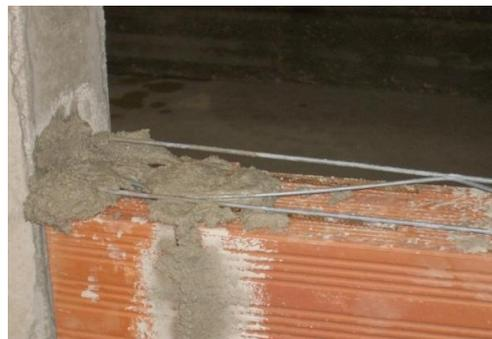
(c) Ligação entre conector metálico e a armadura de junta
