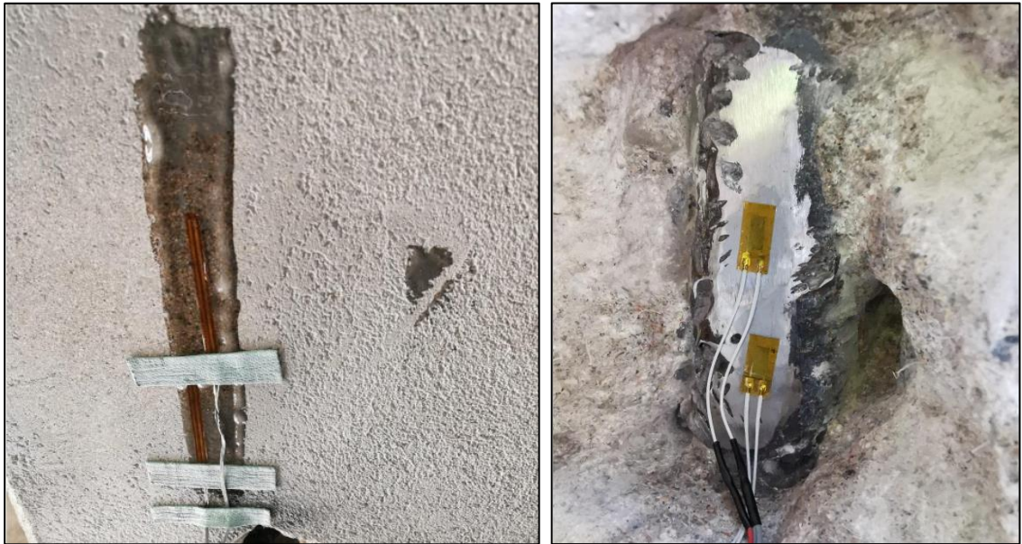
Kuva 28. Vasemmalla betonin pintaan ja oikealla betoniraidoitteeseen kiinnitetyt venymäliuskat (Lyöri 2021).
