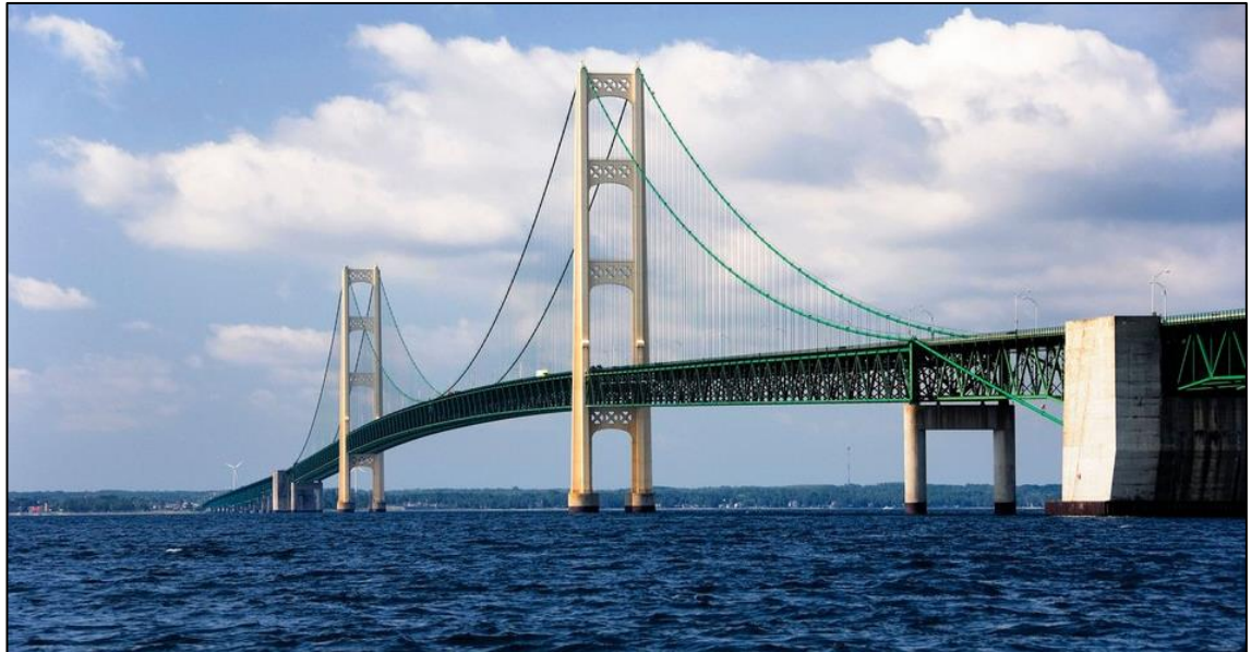
Kuva 22. Mackinac Bridge (Mackinac Bridge Authority 2008).
