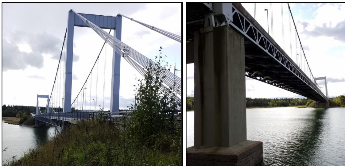
Kuva 19. Kirjalansalmen riippusilta (mukaiillen Taitorakennerekisteri 2019b).
