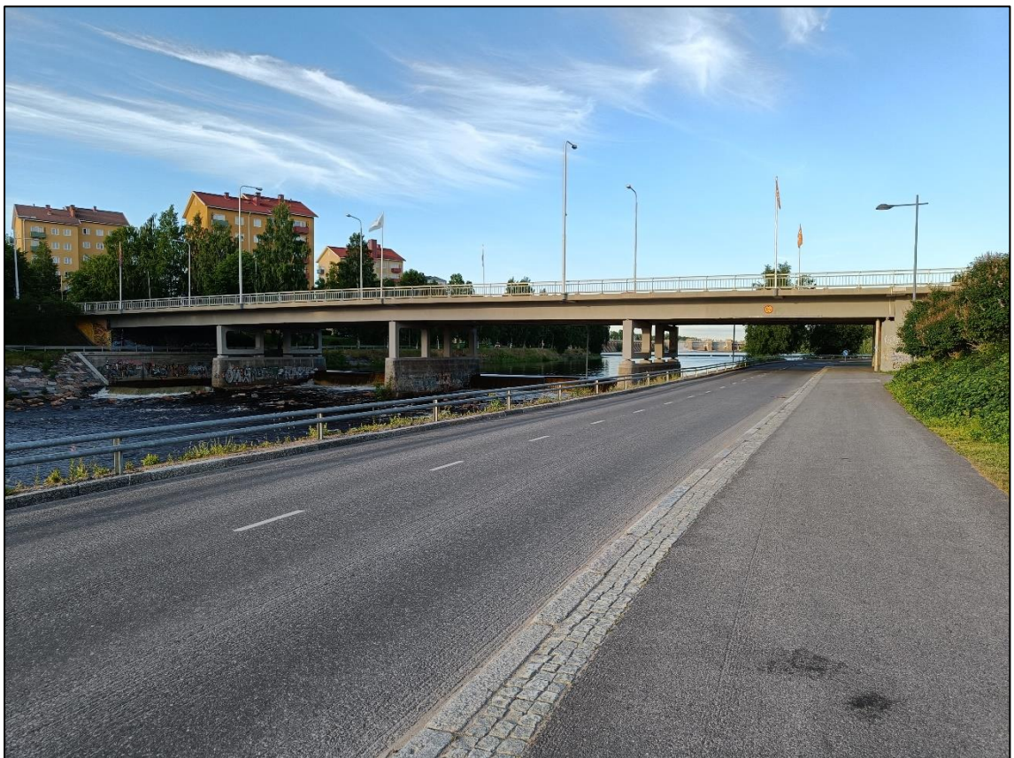
Kuva 25. Tuiranväylän silta (Raudasoja 2022a).
