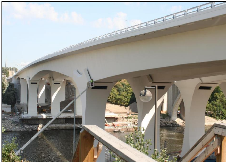
Kuva 16. I-35W Saint Anthony Falls Bridge (SEWilco 2008).
