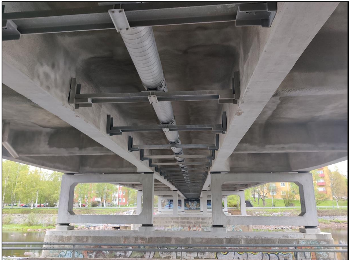
Kuva 26. Tuiranväylän sillan rakenne alhaalta päin katsottuna (Raudasoja 2021).
