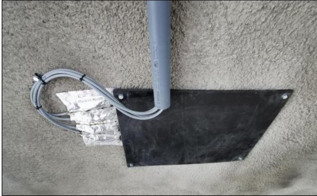
Kuva 30. Valmis anturipaikka. Muovikannen alla sijaitsee betonipintaan ja betoniraudoitteeseen kiinnitetyt venymäanturit (Lyöri 2021).
