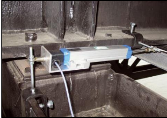
Kuva 20. Lineaarinen liikeanturi mittaamassa Kirjalansalmen sillan kannen ja poikkiristikon välistä liikettä (Tieyhdistys 2009, s. 7).
