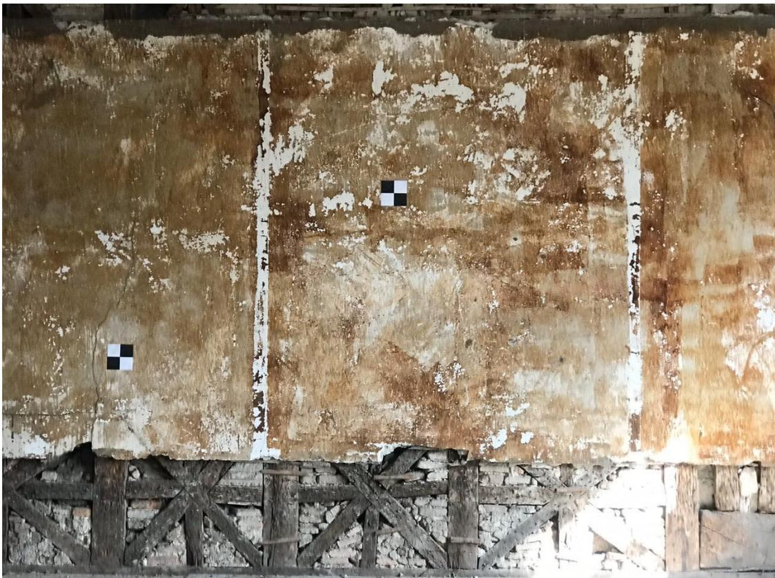
Figura 2 - Parede interna com estrutura em formato de gaiola
