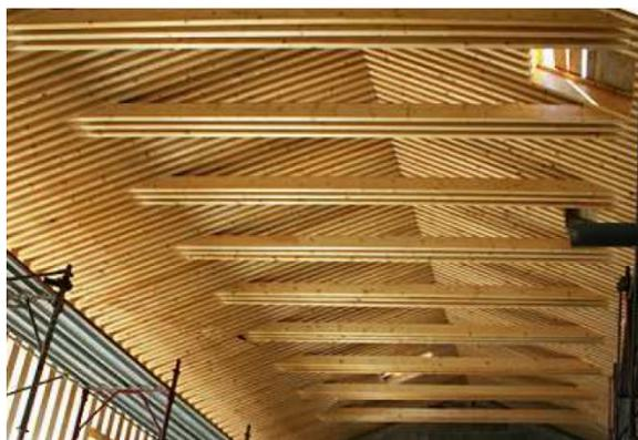
Figura 27 – Telhado véga com tirante
