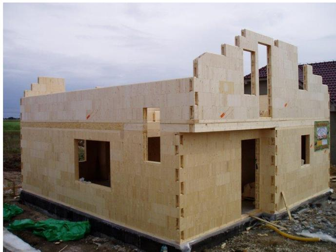
Figura 36 – Construção utilizando sistema Steko
