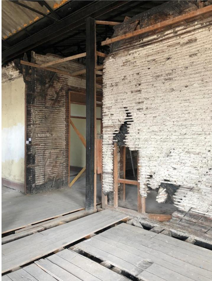
Figura 3 – Parede de tabique reforçado
