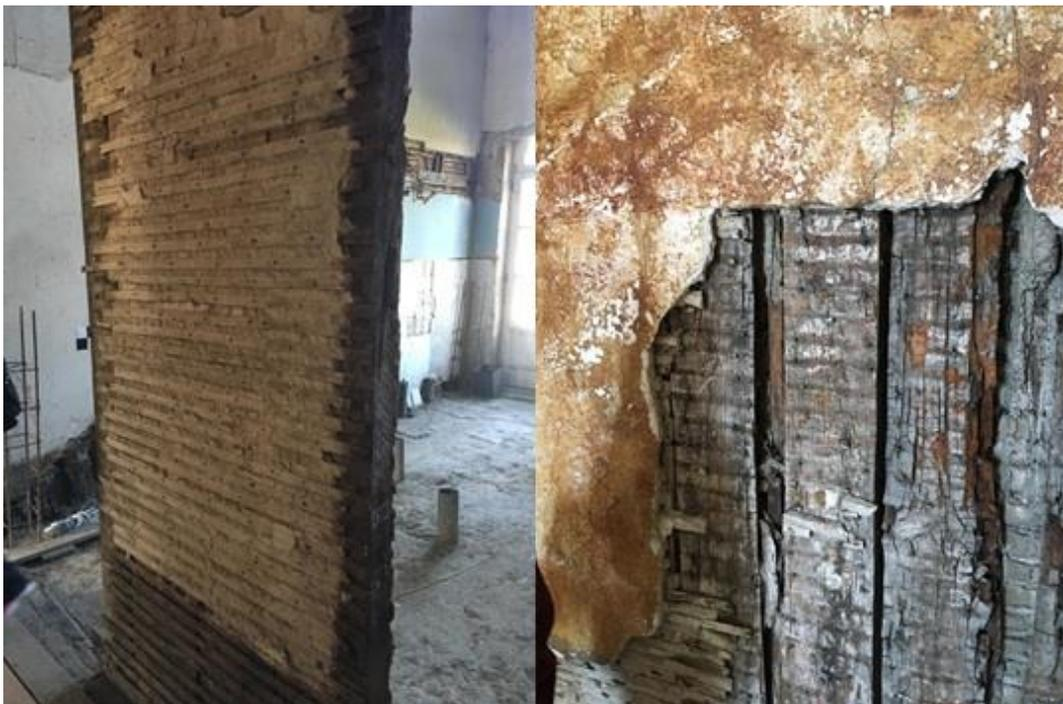
Figura 1 - Representação de paredes de tabique
