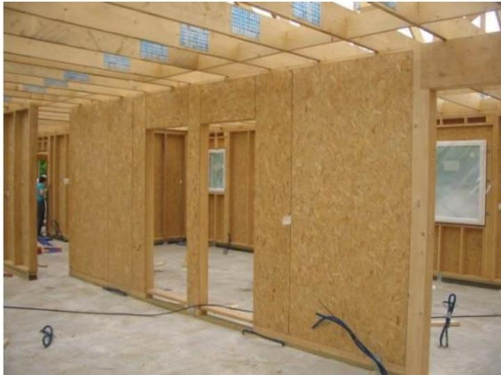
Figura 11 – Painéis de OSB aplicados na construção civil
