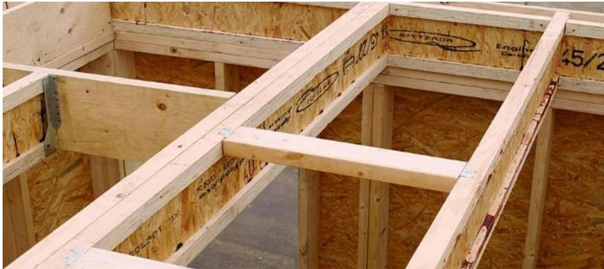
Figura 17 – Estrutura utilizando viga I
