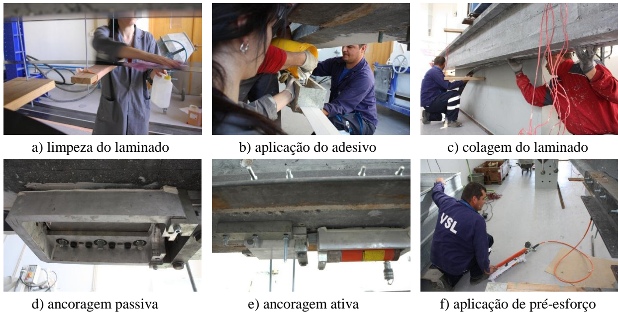
Figura 7 – Procedimento de aplicação do sistema de reforço.
