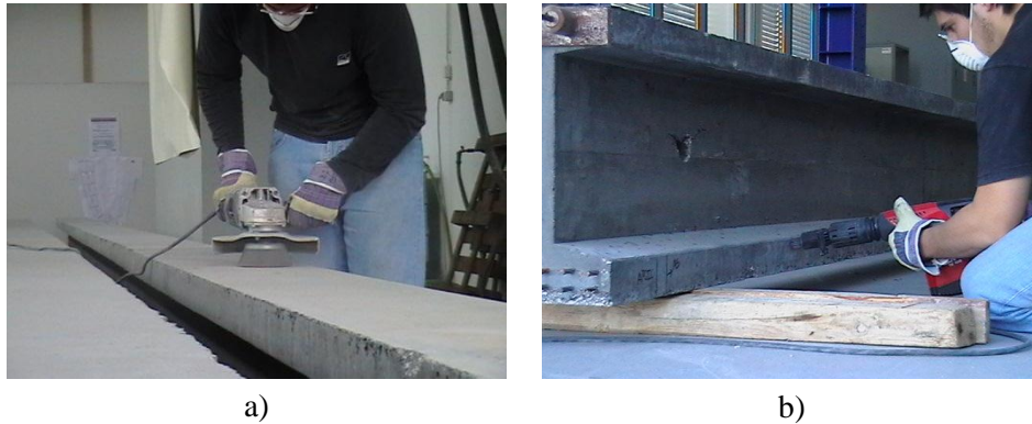
Figura 5 – Tratamento da secção de betão.
