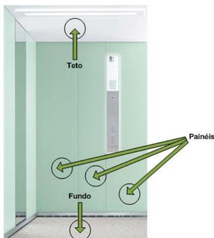
**Figura 39 - Partes constituintes da estrutura interior da caixa do elevador**
